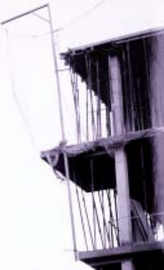
Procés de construcció Edifici B6
