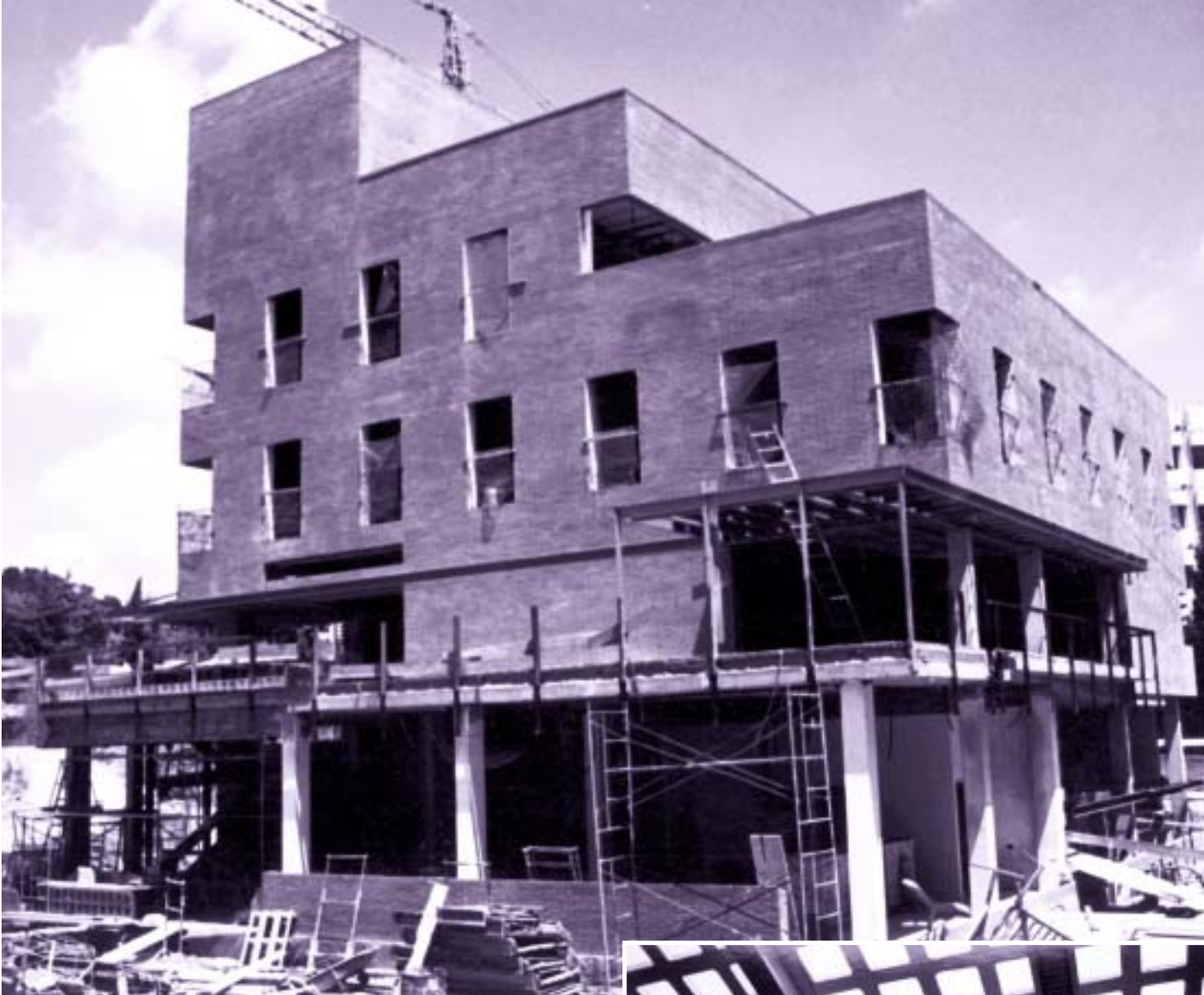
Procés de construcció Edifici B6
